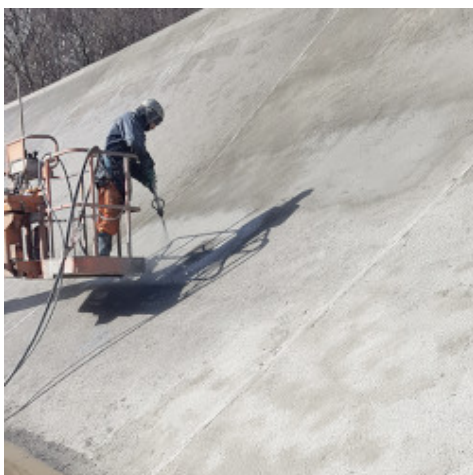
Aplicación de Planiseal 88 con llana
